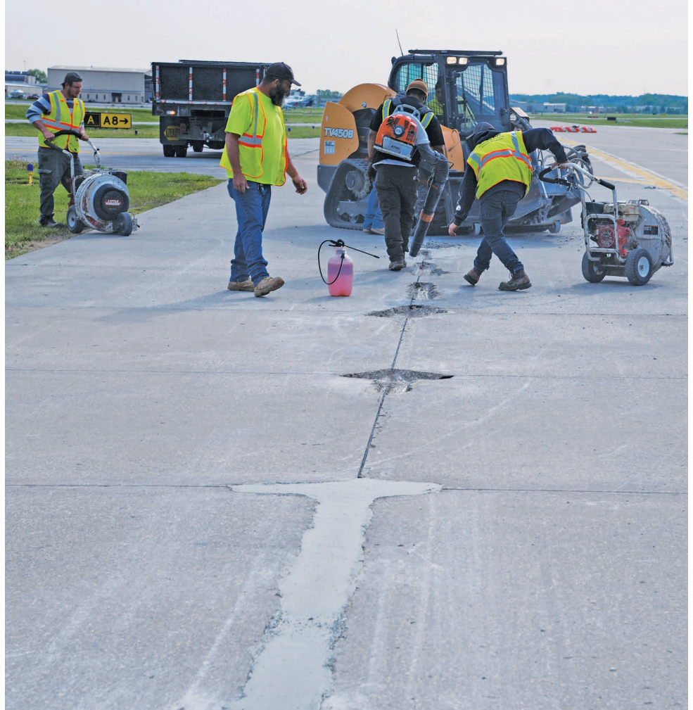
Reparaciones tratadas con TechCrete y más reparaciones en preparación para TechCrete.
