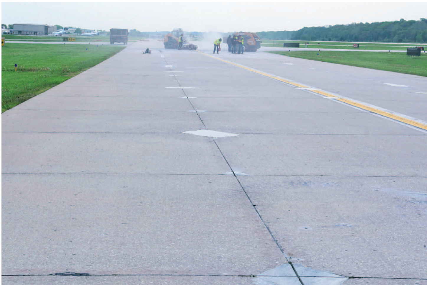
Reparaciones completadas en la calle de rodaje usando TechCrete.
