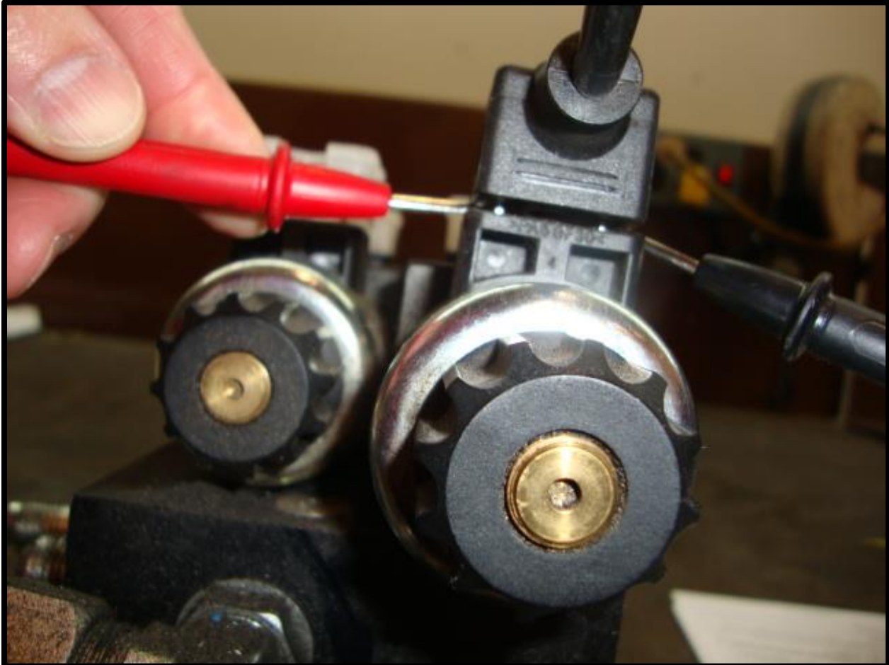
Fig. 8-4 Checking Din Plug Voltage
